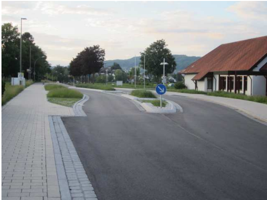
Abbildung 7-6: Neue Querungshilfe in der nördlichen Ortseinfahrt von Kluffern
